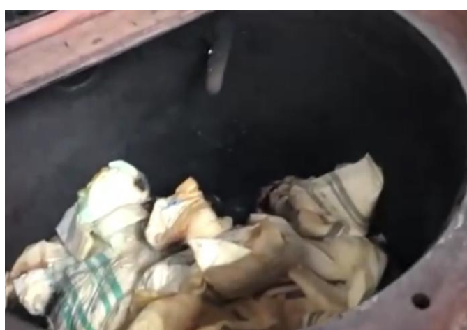
⑤ 炉内状況
